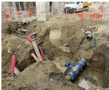
Les branchements aux eaux pluviales et usées sont désormais achevés sur cette rue. L'entreprise ESBTP a ainsi pu combler la tranchée existante, et procéder à un piquetage de la rue pour analyser les différents niveaux.
