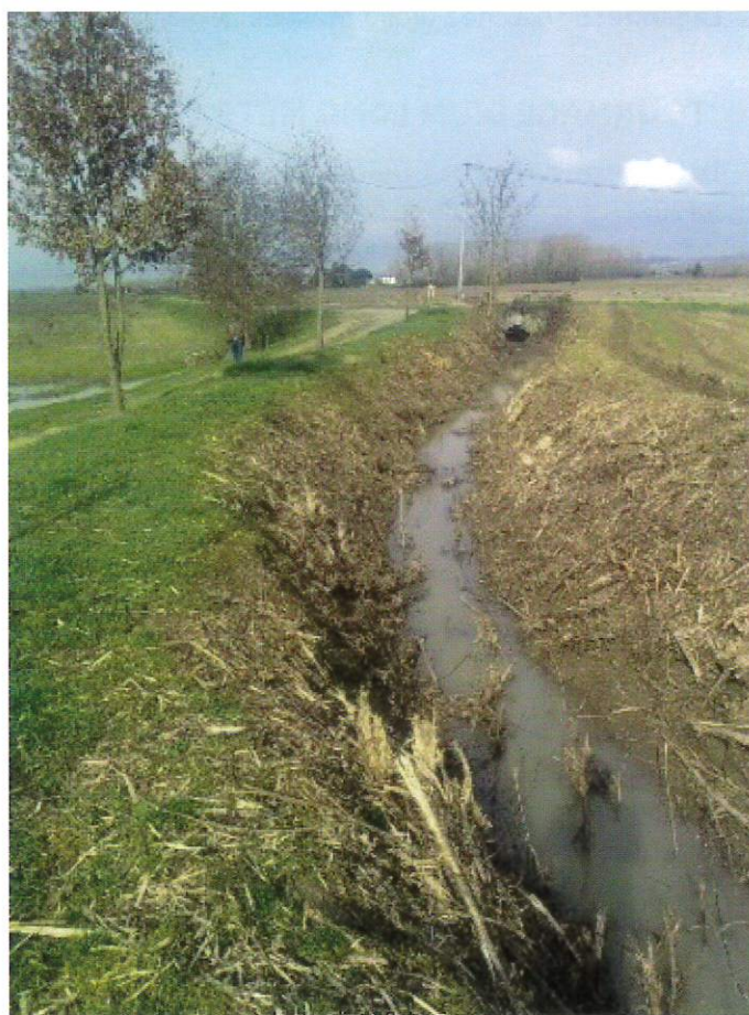
Le curage nécessaire de nombreux fossés.
